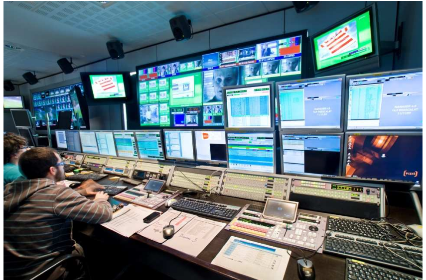
Operarios de continuidad trabajan con sistemas vsnmulticom
